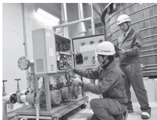
ビルメンテナンスの様子
