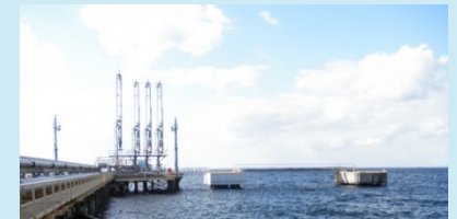
※ 製品出荷棧橋の土台
