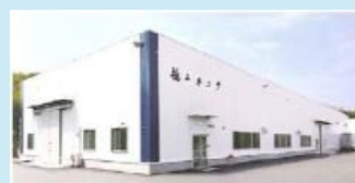
倒壊した工場・施設等の復旧支援
