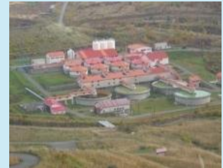
（坑廃水処理施設の例）
