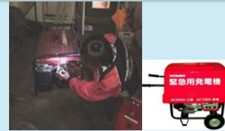
・自家発電機の導入
